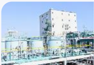
実証プラント
