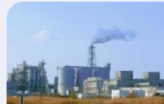
ボイラー（工場）
