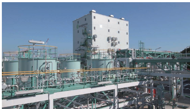
バイオジェット・ディーゼル燃料製造実証プラント
