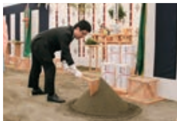
国産バイオジェット・ディーゼル燃料 実証製造プラントの着工式
