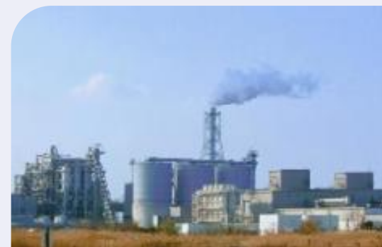
ボイラー（工場）
