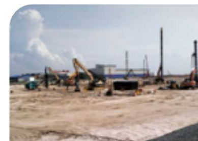
建設現場 (2025年6月)
